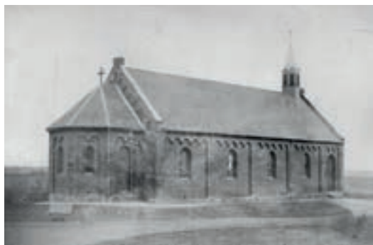
Kirken fotograferet i 1879. I 1906 byggede man kirketårn, kapel og våbenhus til.
